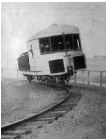
Kreiselstabilisierte Einschienenbahn von Brennan (1907)
